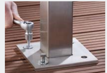
Pfosten ausrichten und montieren.
